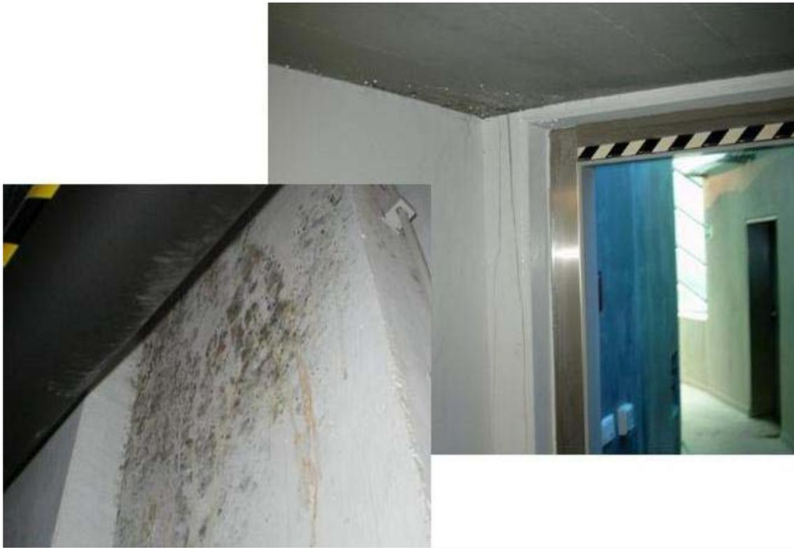
**Abbildung 6:** Darstellung von typischen Feuchteschäden – Schimmelbildung und Tauwasseranfall - bei einer erdberührten, ungedämmten Stahlbetonwand (exemplarisch).
