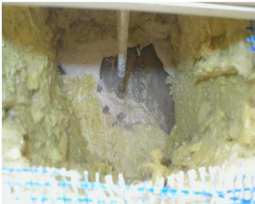
**Abbildung 9:** Dargestellt ist eine lokale Öffnung in einer Dämmebene. Hier wird Tauwasseranfall in der Zwischenschicht „Betonoberfläche – Dämmung“ sichtbar. Eine Dampfsperrschicht wurde nicht angeordnet.
